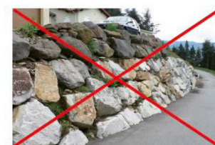
Exemple d'enrochements de type cyclopéen
