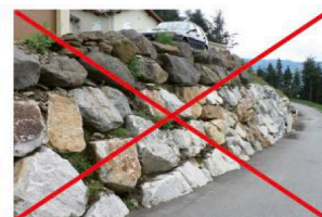
Exemple d'enrochements de type cyclopéen
