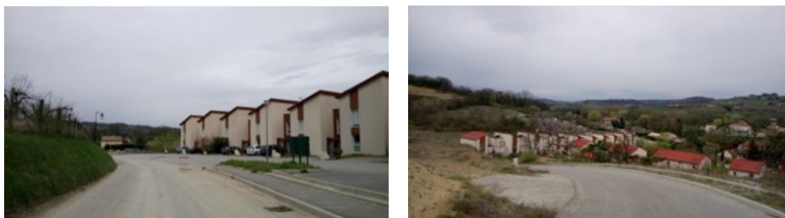
Photos Rue des carrières
