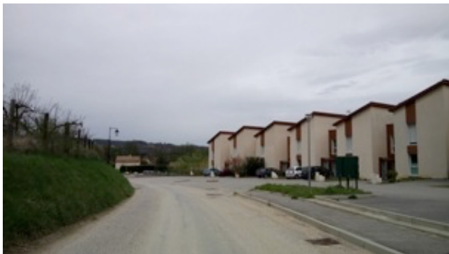
Logements en bande du lotissement des 7 semaines
